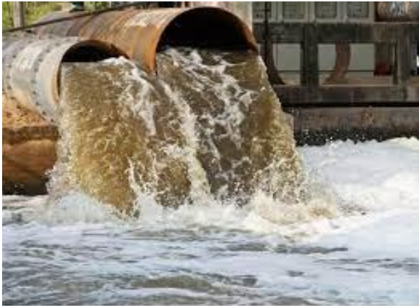
صورة (3) مشروع الصرف الصحي في الرستمية جنوب بغداد
